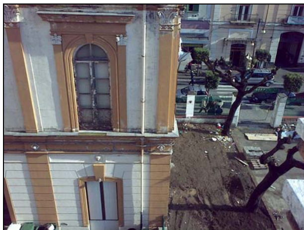
Foto 10 – Il degrado degli infissi esterni
