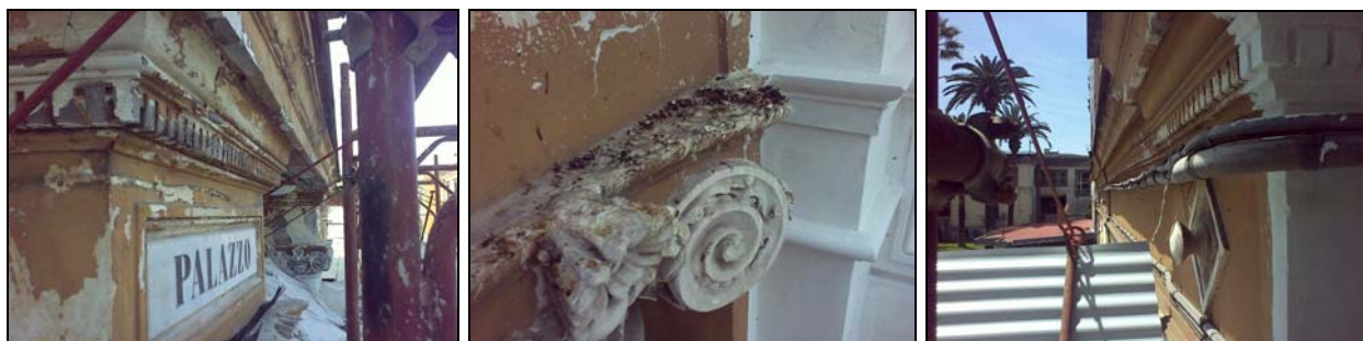
Foto 6,7,8 – Le patologie di degrado dovute all'azione singola e combinata di agenti naturali, artificiali ed antropici
