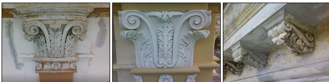
Foto 17,18,19 – Le fasi restauro degli elementi dell'apparato architettonico e ornamentale delle facciate
